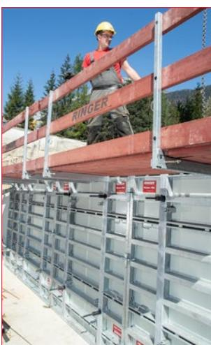
**Platforma za betoniranje „L“**
