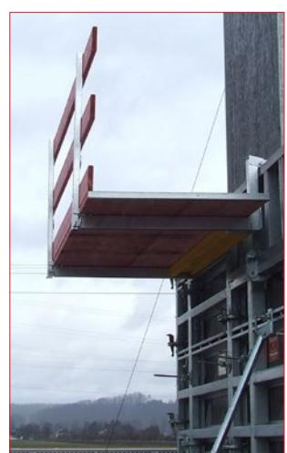
**Platforma za betoniranje „L“
