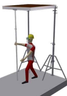
6.) Okrenite oplatni element s polugom za montažu prema gore i ostavite polugu za montažu na mjestu.
